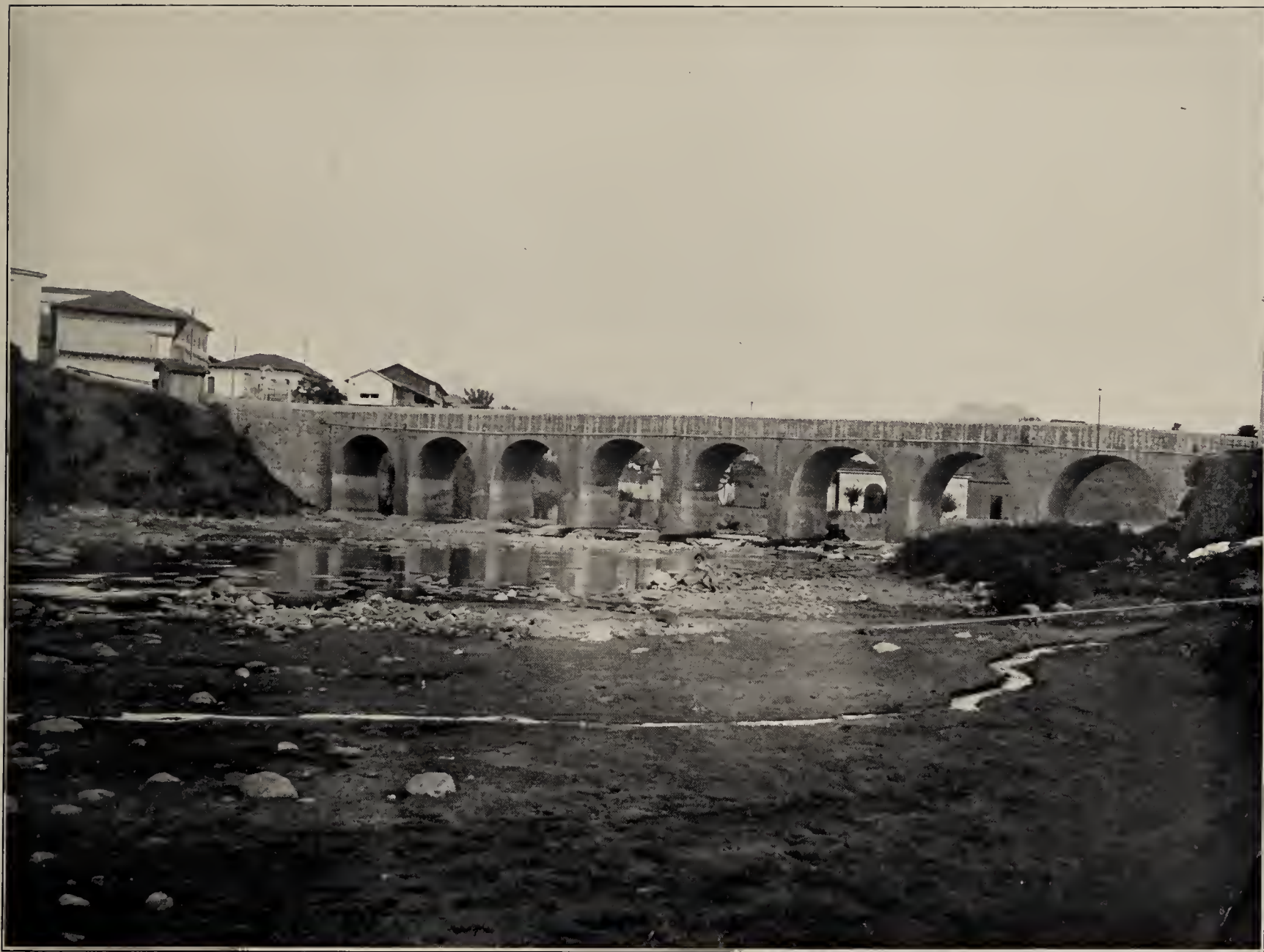
Vista del puente de Tegucigalpa sobre el río Choluteca
